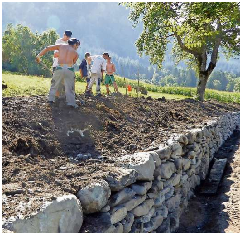
Lernende arbeiten tatkräftig an der Erstellung einer Domleschger Trockenmauer bei Almens mit. (ZVG)
