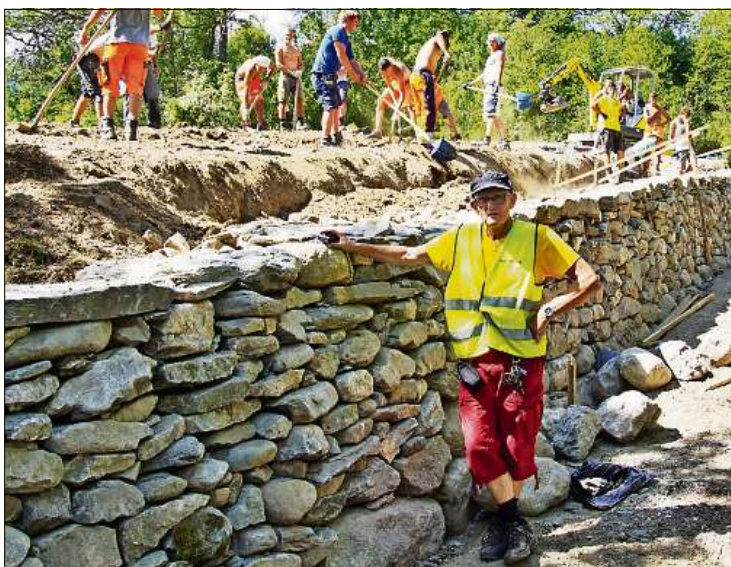
Rudolf Küntzel, Baubeauftragter für Trockenmauern bei der Region Viamala, erklärt die Arbeiten an den Trockenmauern. Bild Herbert Patt
