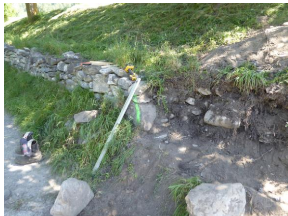
Bild 27 und 28: links sind die schadhaften Stellen sichtbar, rechts geöffneter Abschnitt mit knapper Mauerstärke.
