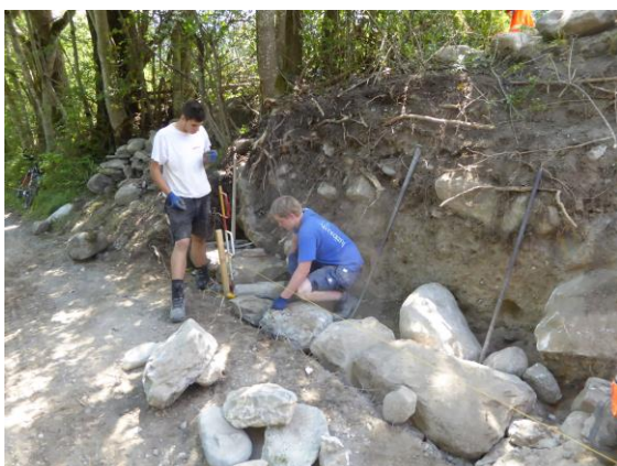
Bild 7 und 8: Fundamentsteine setzen, welcher Stein passt?
