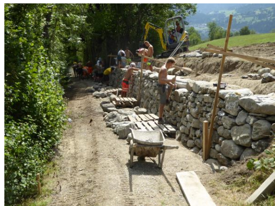
Bild 13 und 14: links der Mauerbau geht in die Endphase, rechts Einbau der Decksteine.
