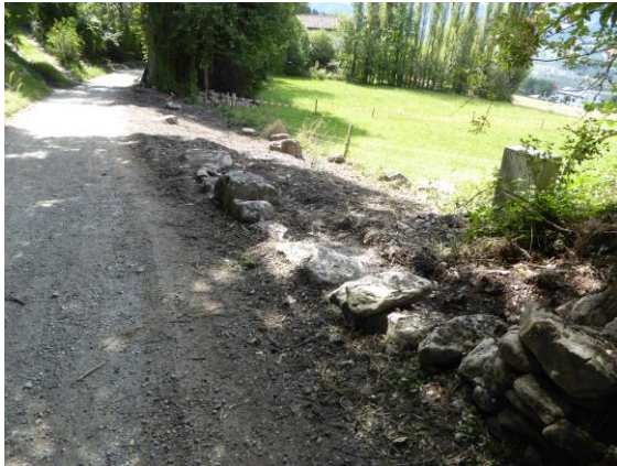
Bild 21 und 22: links Die festsetzenden Fundamentsteine, rechts Steinmaterialbereitstellung.
