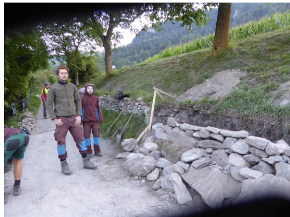
Bild 29 und 30: links ist der schadhafte Abschnitt freigelegt, rechts geöffneter Abschnitt mit neuem Fundament.
