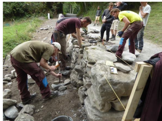
Bild 23 und 24: links die Fundamentsteine sind gesetzt, rechts südliches Mauerende fertig.
