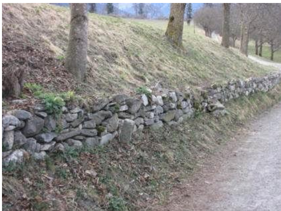
Bild 27 und 28: links sind die schadhaften Stellen sichtbar, rechts geöffneter Abschnitt mit knapper Mauerstärke.
