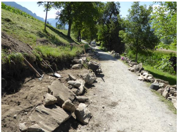
Bild 29 und 30: links ist der schadhafte Abschnitt freigelegt, rechts geöffneter Abschnitt mit neuem Fundament.
