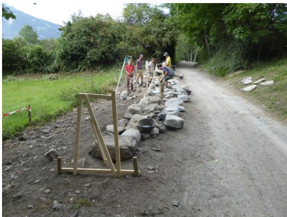
Bild 23 und 24: links die Fundamentsteine sind gesetzt, rechts südliches Mauerende fertig.
