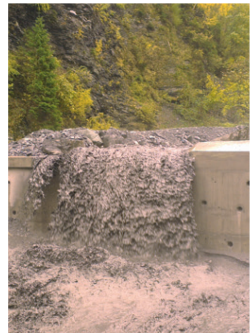
Nolla Sperre Nr. 3 während Sanierung 2013
