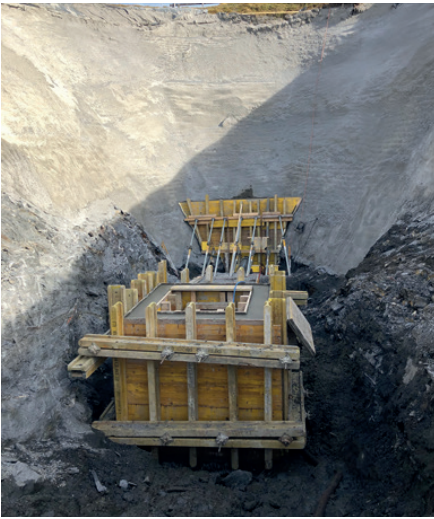
Betonarbeiten Grundablass und Betonzapfen für Stollenverschluss
