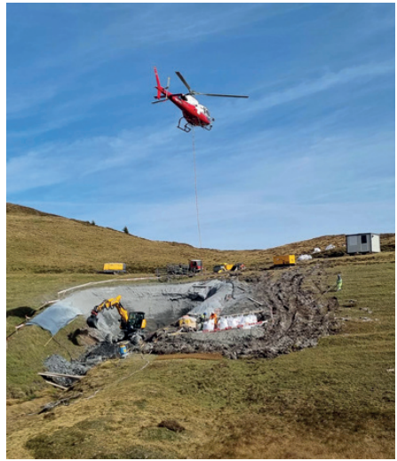
Helitransport von Spritzbeton zur Baustelle
